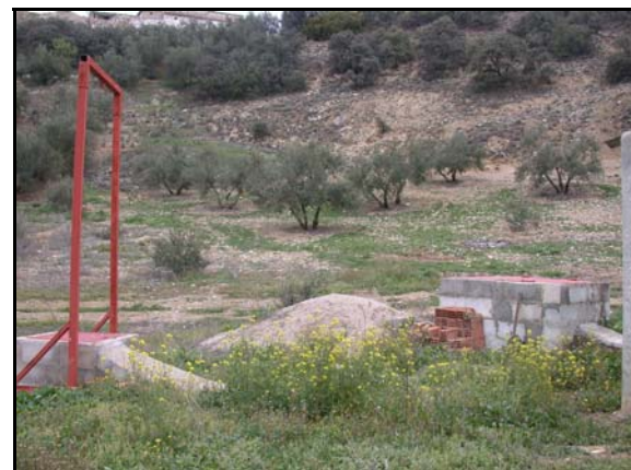
Foto de la instalación
