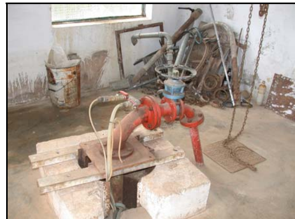
Foto de la instalación
