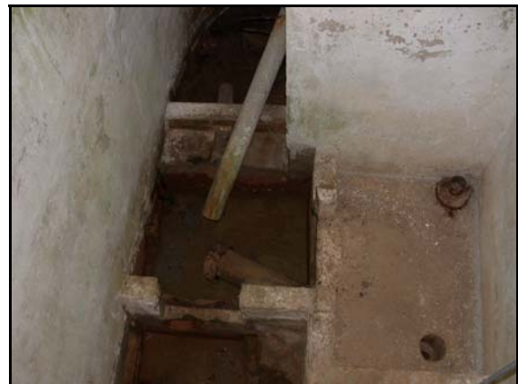
Foto de la instalación
