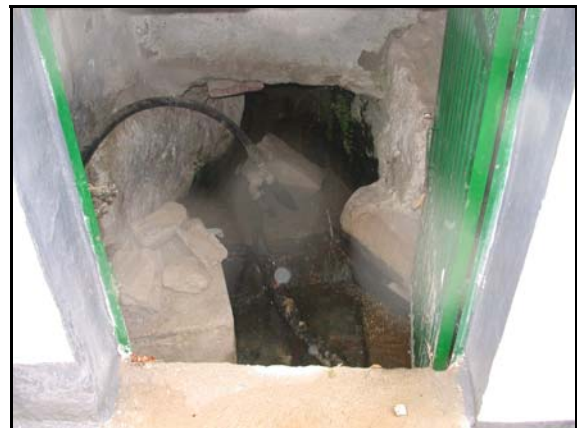
Foto de la instalación
