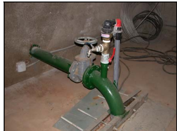
Foto de la instalación
