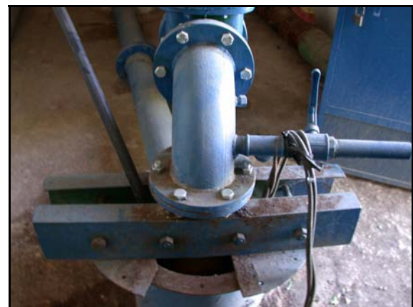
Foto de la instalación
