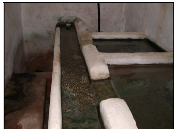
Foto de la instalación
