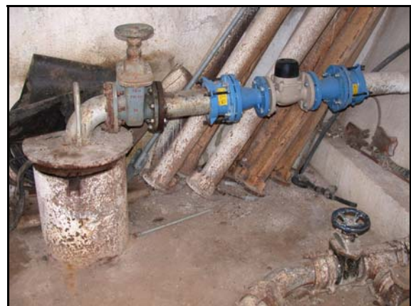
Foto de la instalación
