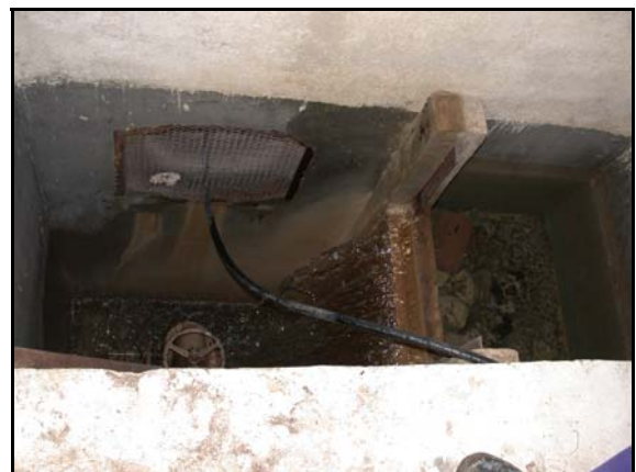
Foto de la instalación
