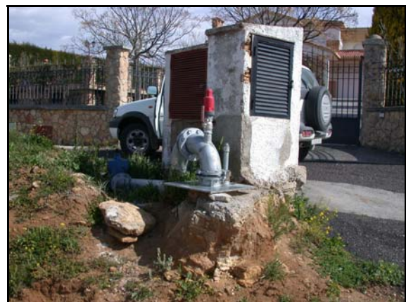
Foto de la instalación
