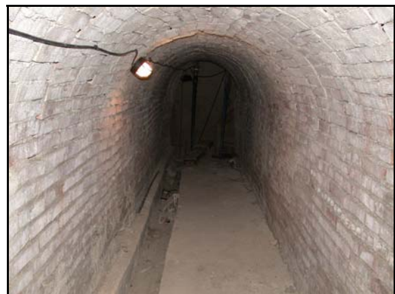
Foto de la instalación
