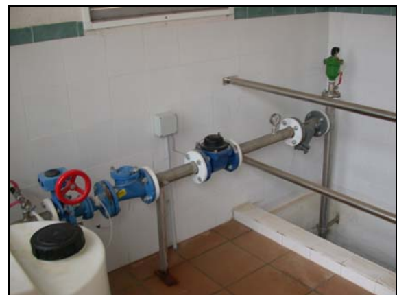
Foto de la instalación
