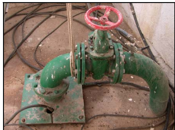
Foto de la instalación
