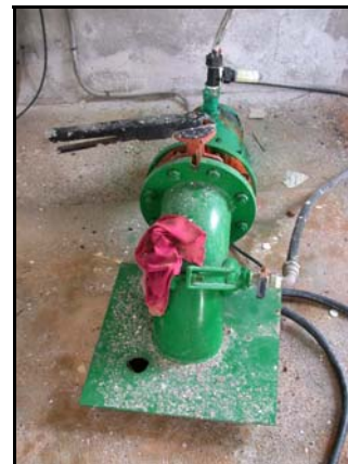
Foto de la instalación
