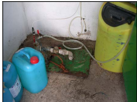
Foto de la instalación
