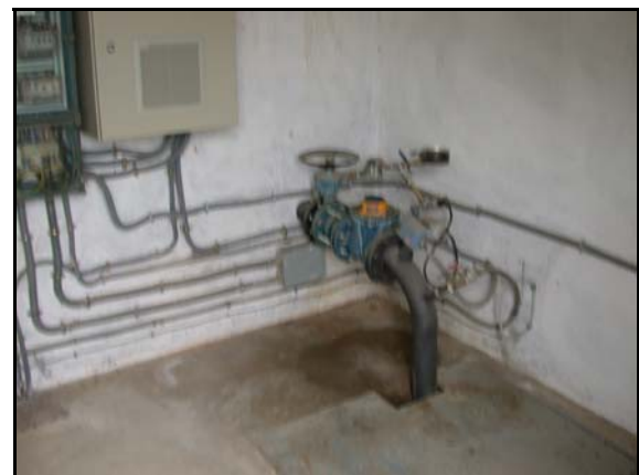
Foto de la instalación
