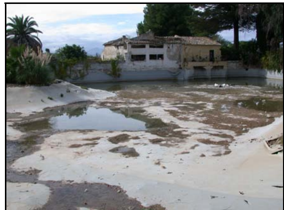
Foto de la instalación
