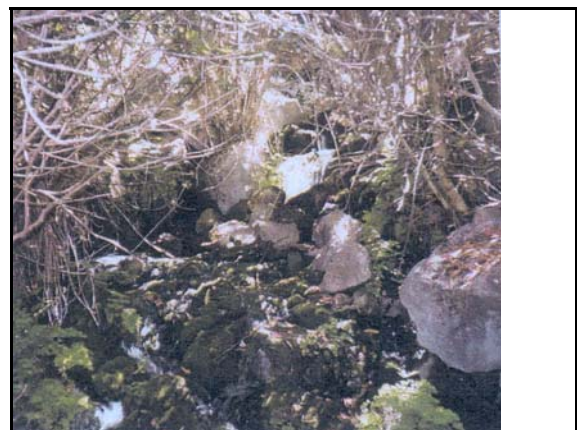
Foto de la instalación
