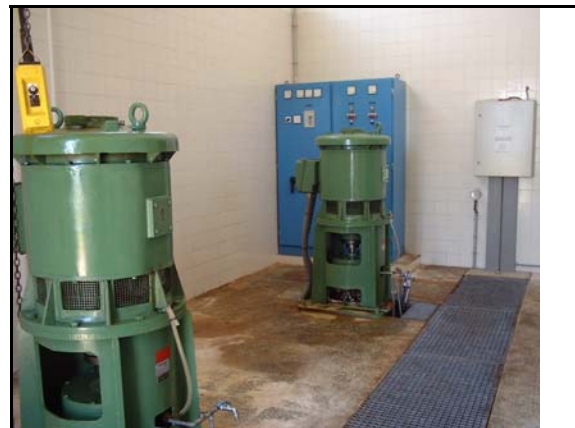
Foto de la instalación
