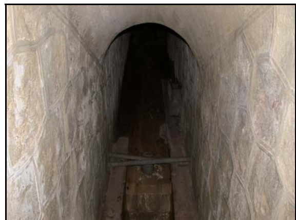
Foto de la instalación
