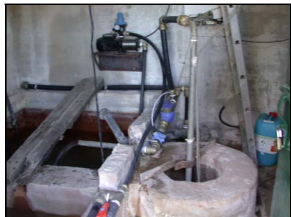
Foto de la instalación
