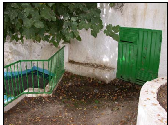
Foto de la instalación
