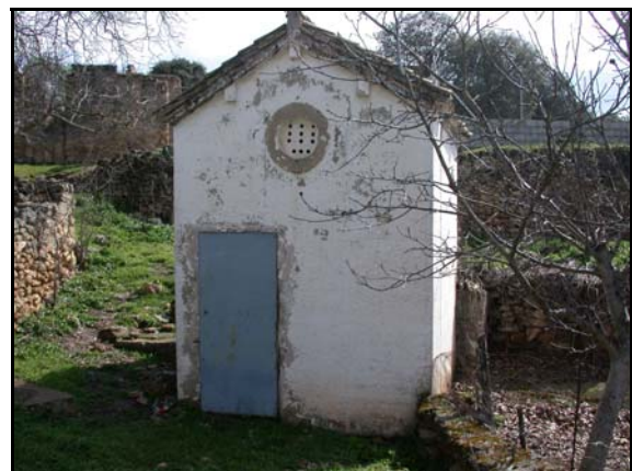
Foto de la instalación
