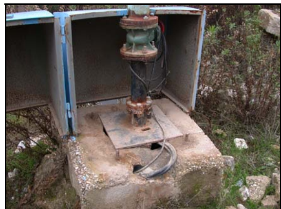
Foto de la instalación
