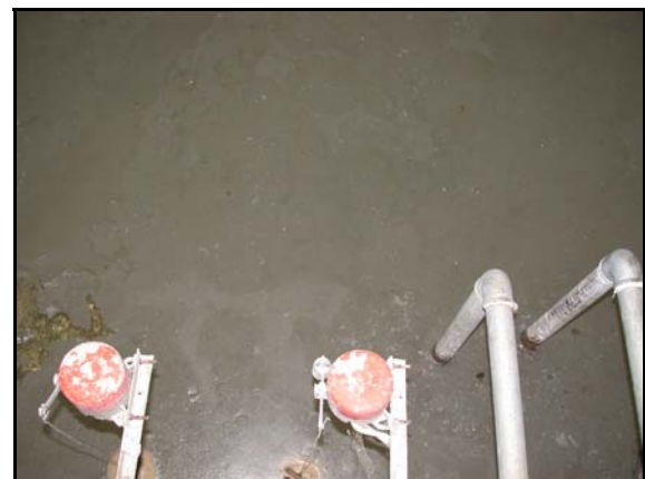
Foto de la instalación
