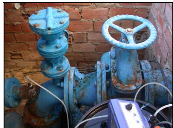
Foto de la instalación
